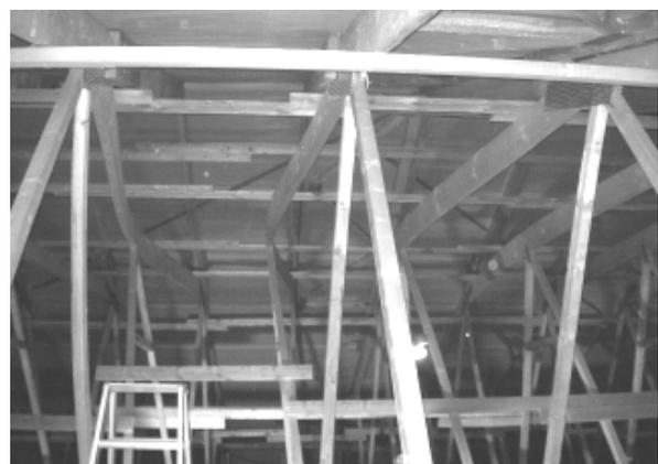
Abb. 4: Schadensbild der ausgewichenen horizontalen Obergurte der Nagelplattenbinder des Plus-Marktes
