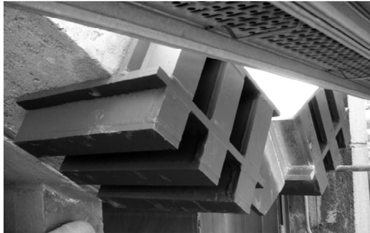
Abb. 5: Vormontiertes Verankerungselement aus Stahl
