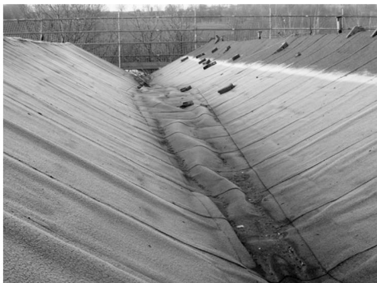
Abb. 2: Schäden an der Dachhaut durch erhebliche Blasenbildung
