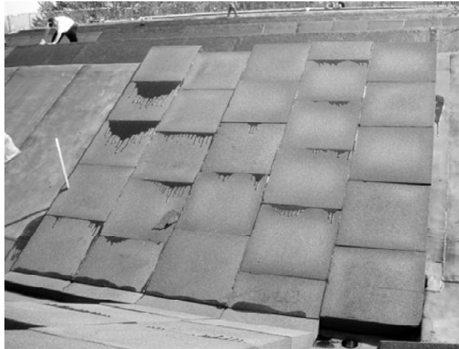
Abb. 7: Vollflächige Verlegung der Schaumglasplatten im Verband mit Heißbitumen
