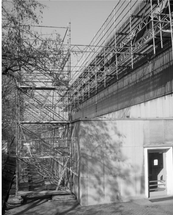
Abb. 4: Abfangung des Außengerüsts an der südlichen Hallenlängsseite
