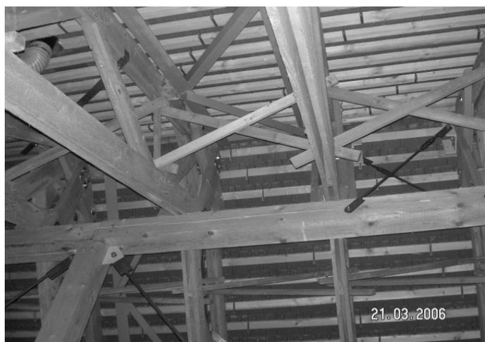
Abb. 5: Sanierungsvorschlag durch Einbau zusätzlicher vertikaler und in Dachebene liegender Verbände
