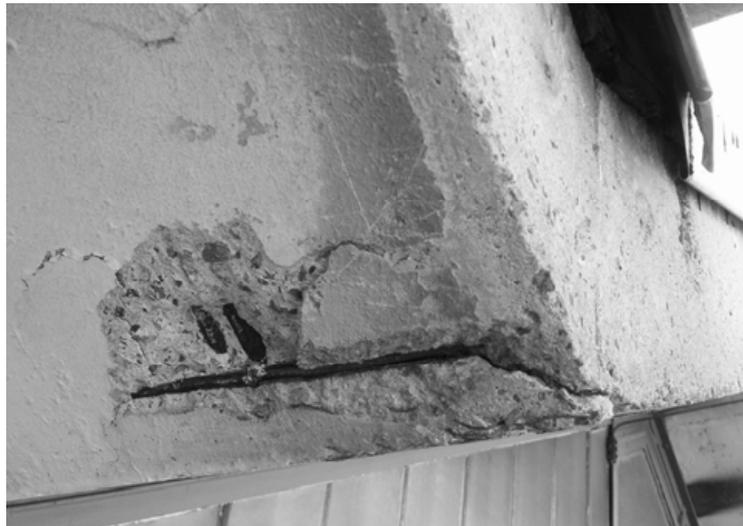
Abb. 3: Schäden am Beton und Korrosion der Bewehrung
